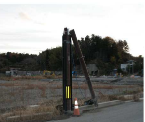
折れ曲がったままの電柱 (JR常盤線富岡駅跡地付近)
